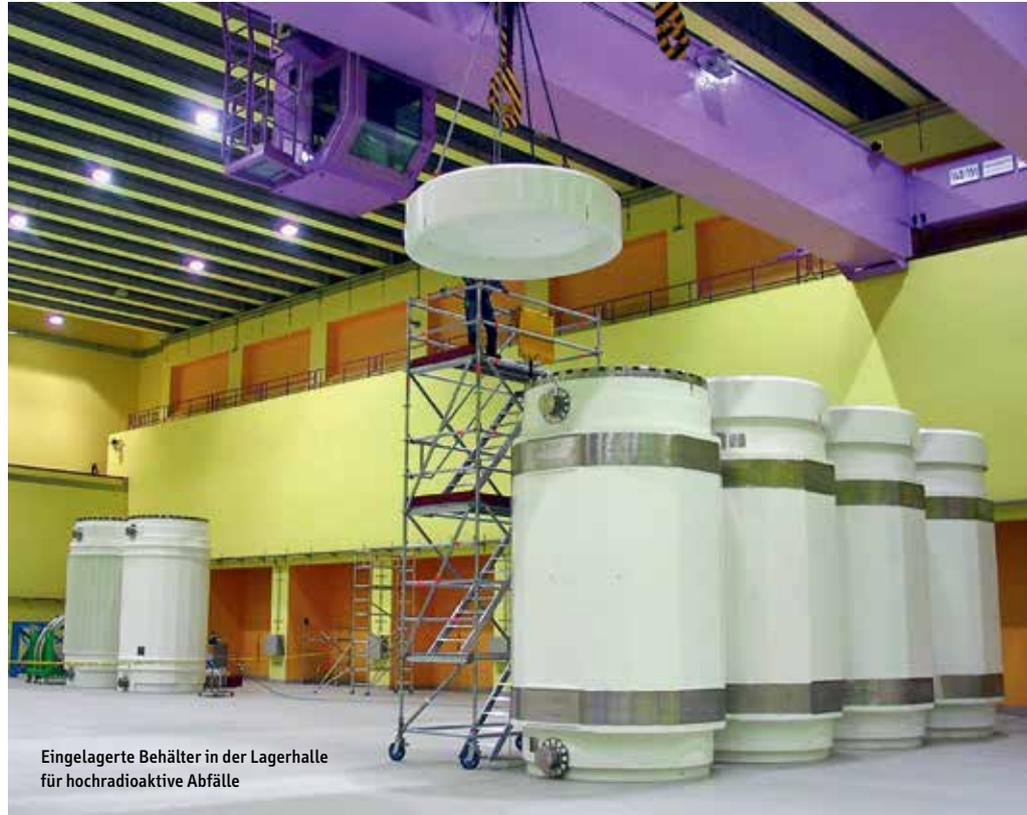
Eingelagerte Behälter in der Lagerhalle für hochradioaktive Abfälle
