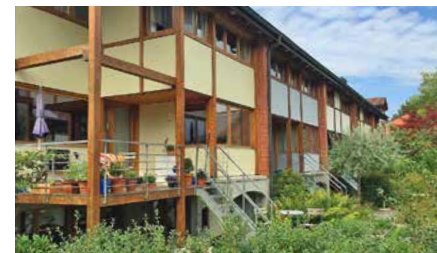
Energetische Massnahmen sind nötig geworden: Die 1982 erbaute Reihenhaussiedlung «Im Heugarten» in Mönchaltorf ZH.
