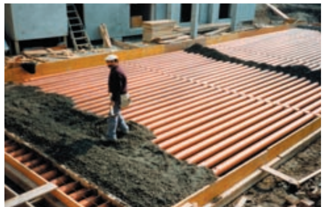
Erdregister während der Verfüllung mit magerem Beton. Die parallel geführten Rohre sind 21 m lang.
