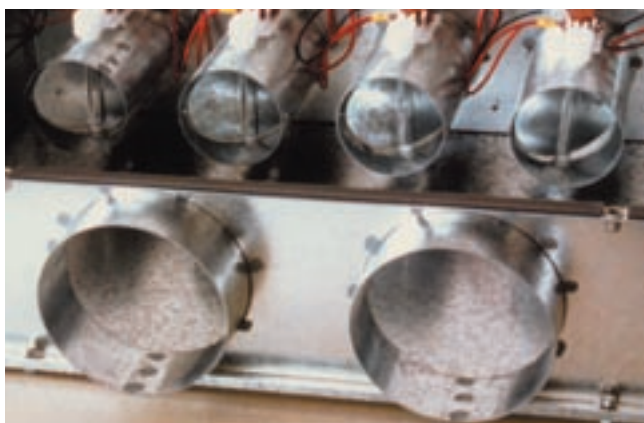
Sammelkasten für Zu- oder Abluft einer Wohnung (zimmerseitige Anschlüsse hinten).
