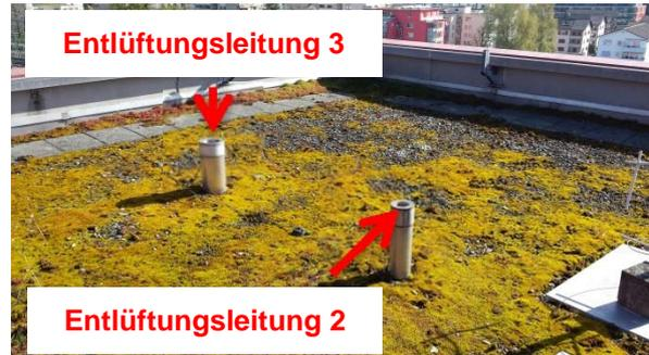
Abbildung 23: Entlüftungsleitung 2 (rechts), Entlüftungsleitung 3 (links),
