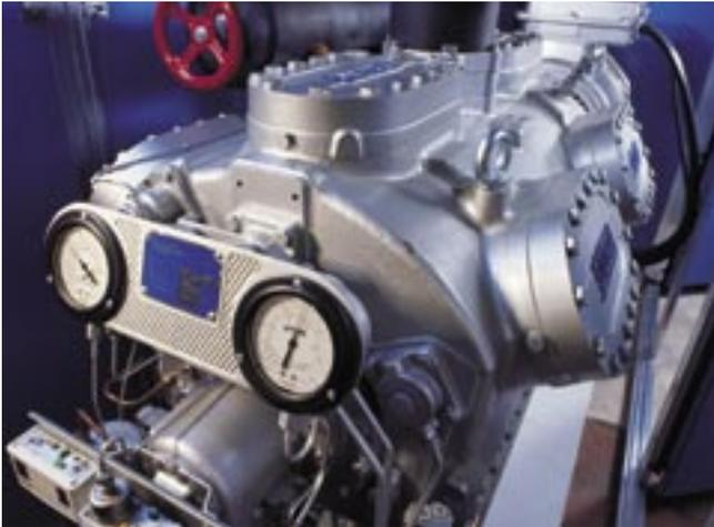
Diese Wärmepumpe entzieht dem Grundwasser rund 500 kW Wärme und stellt damit 605 kW Heizleistung bereit. (EWZ)
