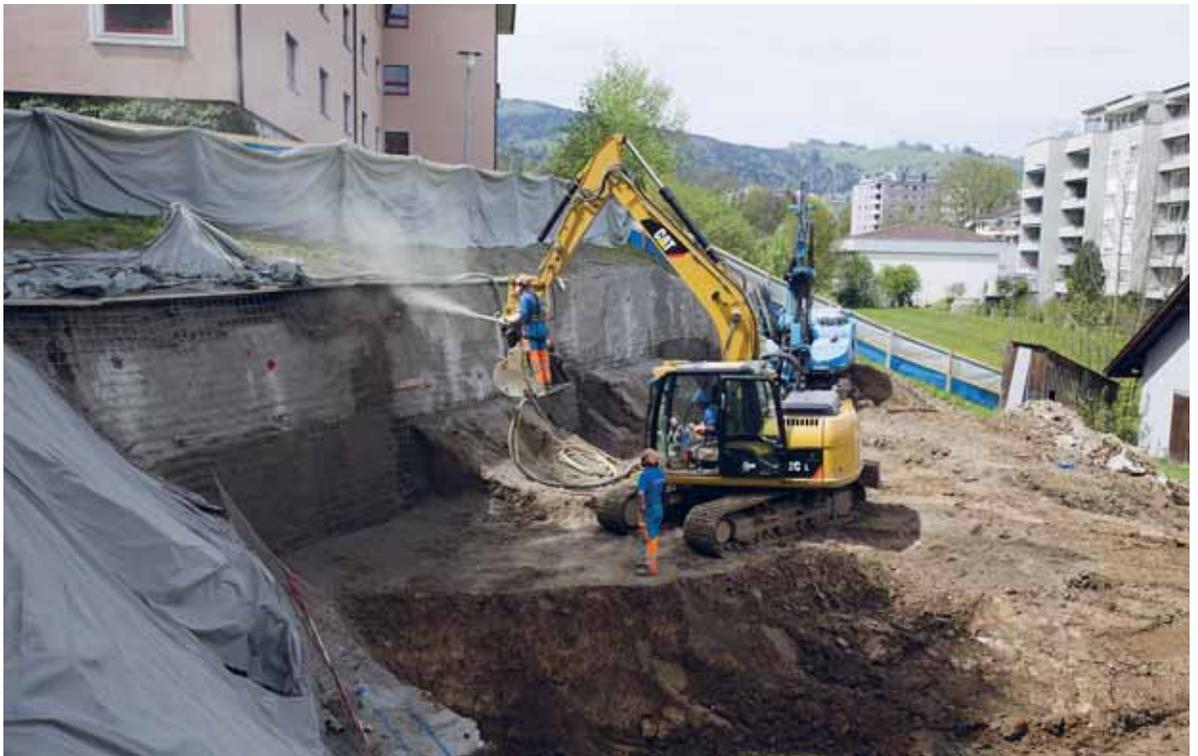
Abbildung 96: Baugrube des MFH Kirchrainweg mit abgetrepter Sole zur Reduktion des Aushubvolumens (Foto: aardeplan).
