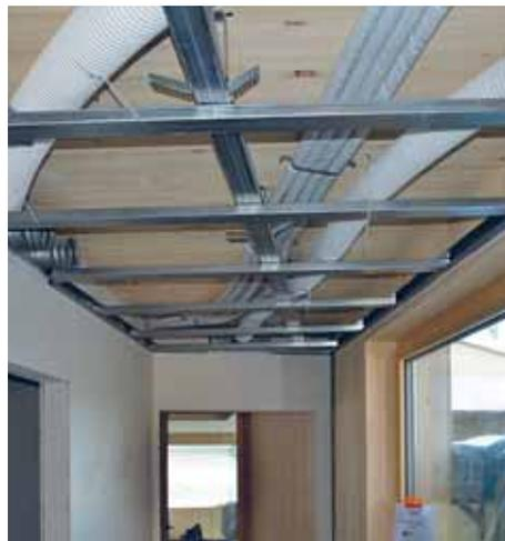
Abbildung 106: Abgehängte Decke im MFH Kirchrainweg mit nicht in Betondecke eingeleiteten Lüftungs- und Elektrorohren als Beispiel für Systemtrennung (Foto: aardeplan).
