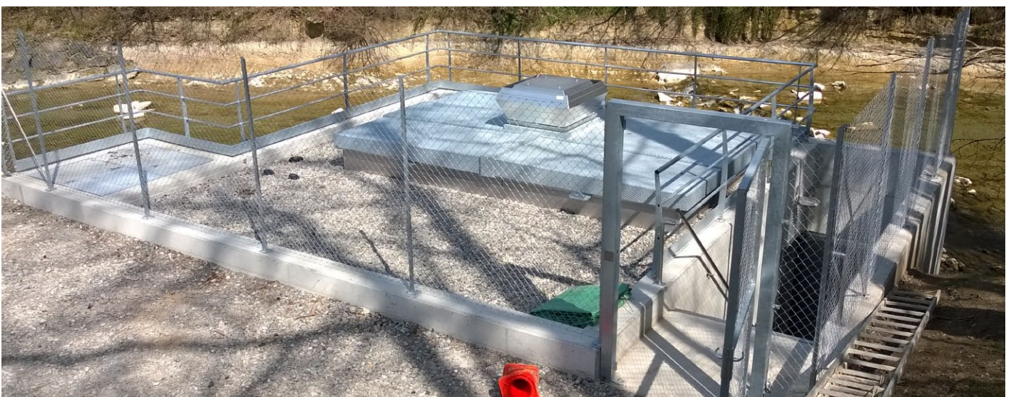
Die Maschinenzentrale an der Töss
