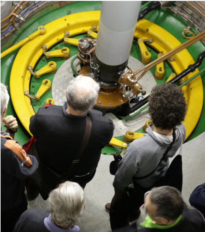
Besichtigung der Dotierturbine der Barrage de la Maigrange, anlässlich der ISKB Fachtagung
