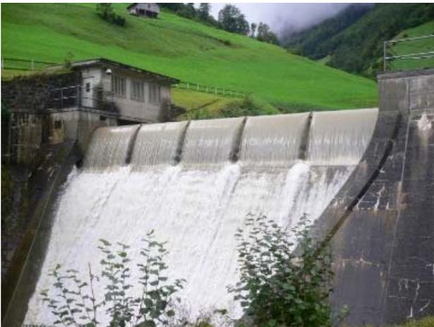
**Abbildung 5: Hochwasserentlastung Stauanlage Isenthal, Kt. UR**
