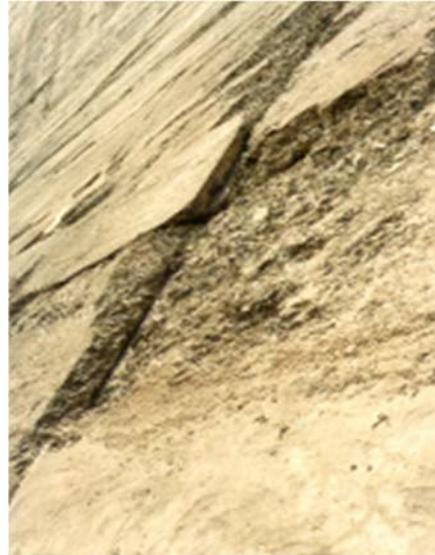
**Abbildung 8c: Abplatzungen an einer Staumauer**
