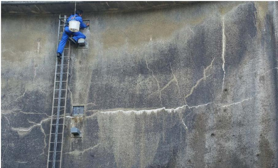
**Abbildung 8d: Rissbildung an einer Staumauer**
