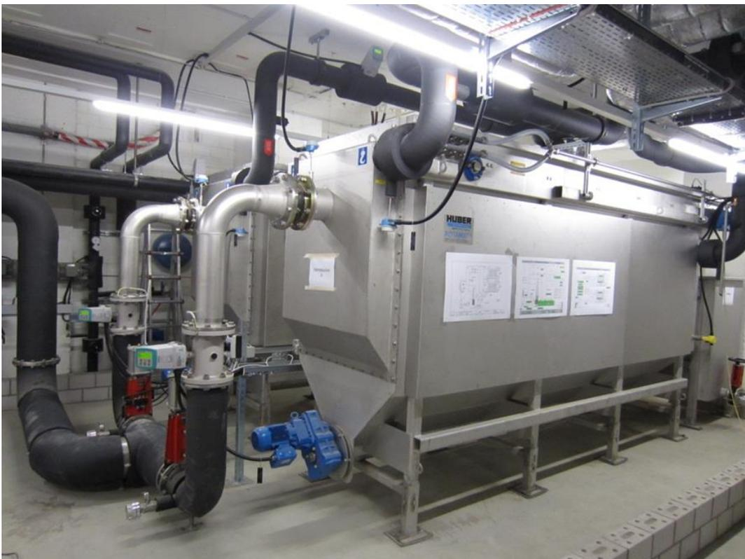
Abbildung 12: Zwei selbstreinigenden Wärmetauschern mit je 25 l/s Durchsatz von Picatech Huber AG
