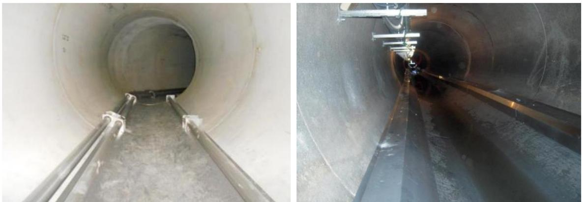
Abbildung 15: Beispiel-Installationen von Kanalwärmetauscher Typ „SEWER“ [Kasag]
