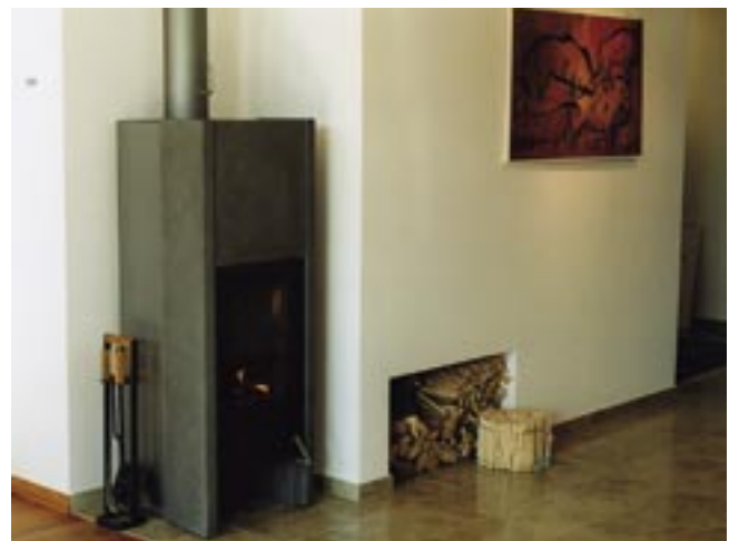
Der Holzspeicherofen im Zentrum des Hauses ist an die Zentralheizung angeschlossen.
