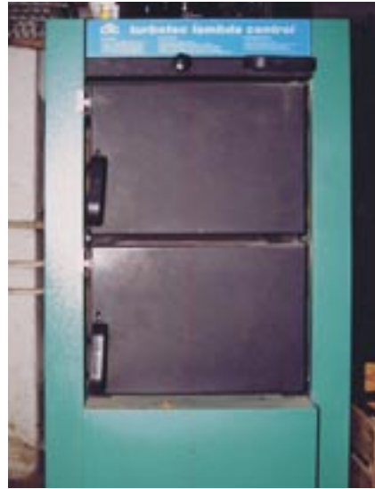
Holz-Zentral- heizungskessel der Familie Bigler.
