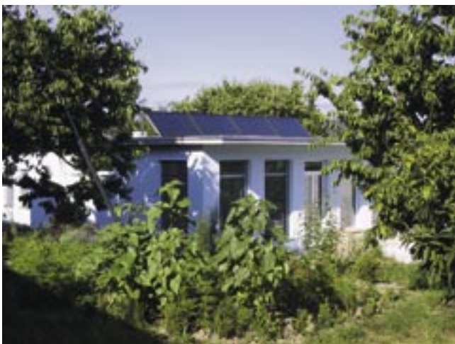
Das blaue Haus in Kölliken: Die Sonnenkollektoren auf dem Dach unterstützen die Holzheizung.
