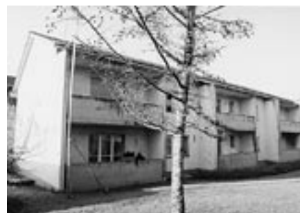
Das Gebäude vor der Sanierung.
