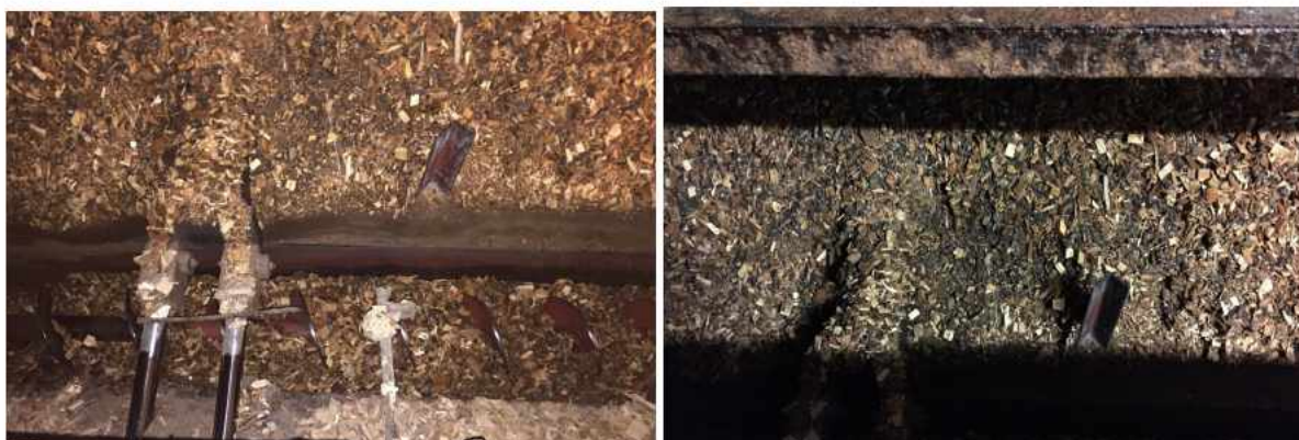
Bilder: Zwischenlager in Muttenz, Brennstoffsilo und der Schubodenausgang der Anlage
