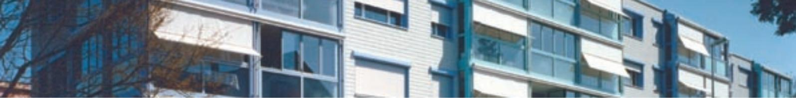
beträgt bis zu 15 %. Voraussetzung sind allerdings ein optimales Benutzerverhalten und der Einsatz von Wärmeschutzglas. Im anderen Fall kann ein verglaster Balkon auch zu Mehrverbrauch an Energie führen. Ein zusätzlicher Nutzen der Balkonverglasung besteht im Schutz vor Schlagregen und Strassenlärm. Nachteil: Die Belichtung der dahinter liegenden Wohnräume mit Tageslicht wird eingeschränkt.
