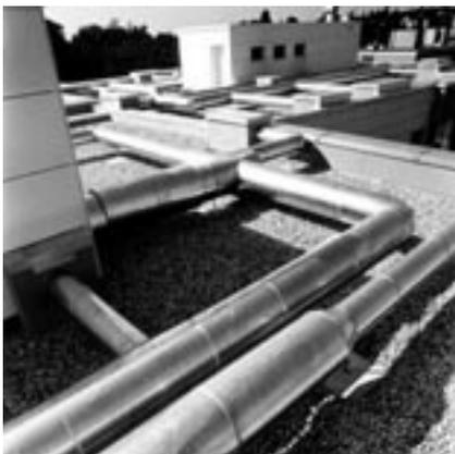
Einbettung der Zuluftkanäle in die innere Schicht der Wärmedämmung.
