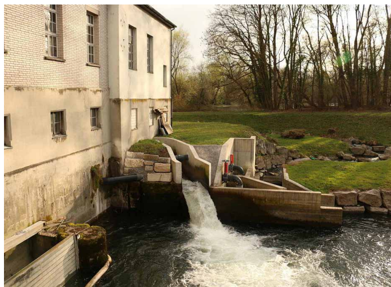
Fischabstiegshilfe und Umgehungsgewässer beim Kraftwerk Stroppele an der Limmat.
