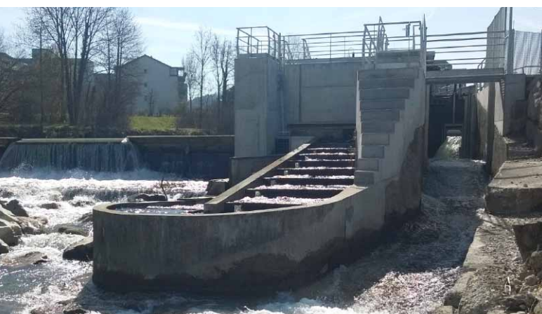
Fischaufstieg und Fischabstieg Kleinwasserkraftwerk Hard
