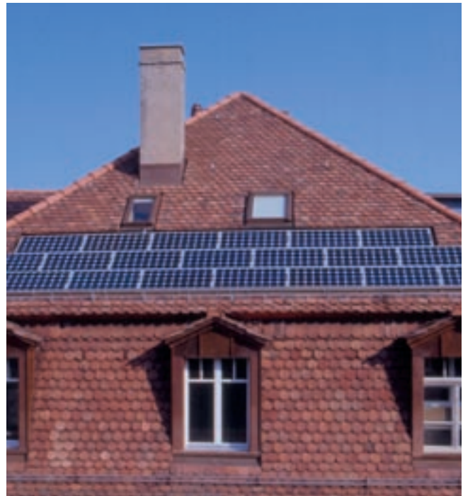
Die Solarzellen auf dem Dach liefern jährlich 1400 kWh.
