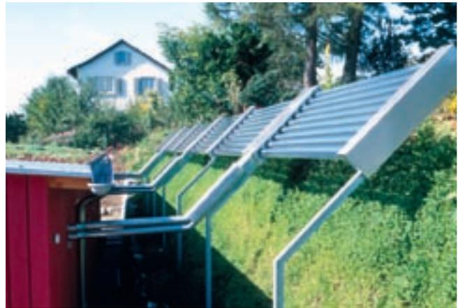
Warmwasser aus erneuerbarer Quelle: Hinter dem Haus sind 12m<sup>2</sup> Röhrenkollektoren für die solare Wassererwärmung installiert.
