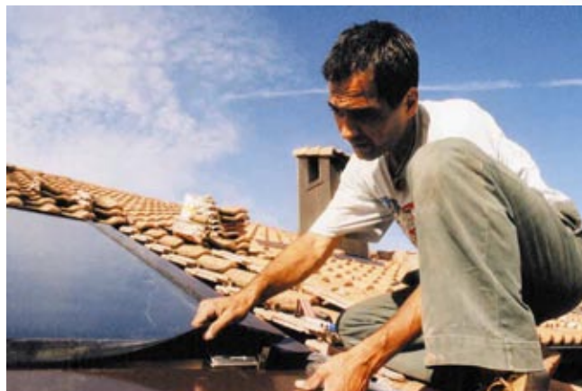
Erdgas und Sonne bringen Wärme ins Haus: Eine standardisierte Solaranlage für Warmwasser ist beim Einfamilienhaus in einem Tag installiert.
