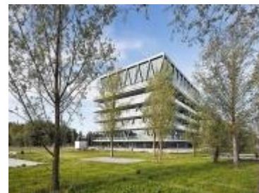
Abb. A. 8 Neubau Schulhaus F
