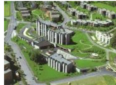
Abb. A. 15 Altersheim B vor Sanierung
