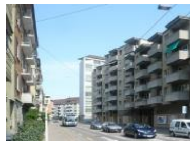
Abb. A. 18 Wohnsiedlung A vor der Sanierung
