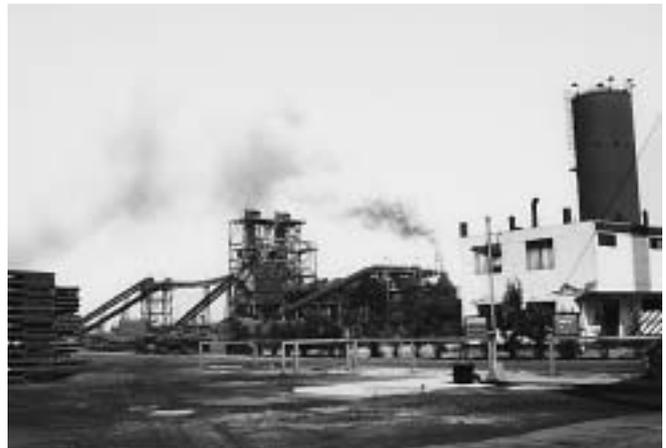
Kernstück der Studie des *Cleaner Production Centers* in Peru ist die Rückgewinnung von Wärme. Über Wärmetauscher wird Wasserdampf produziert, der in einer Dampfturbine zu Strom umgewandelt wird. Folgende Umwelteffekte wurden ausgemacht:
