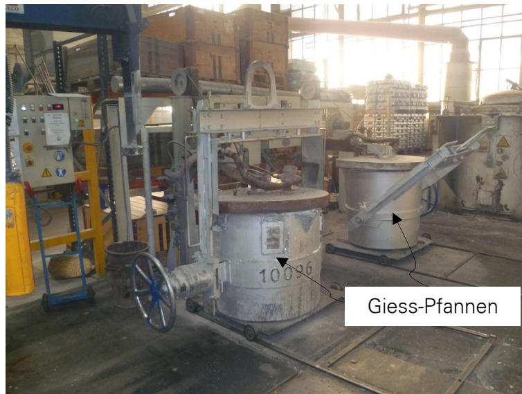
Abbildung 5: Pfannenvorwärmstation im Betrieb
