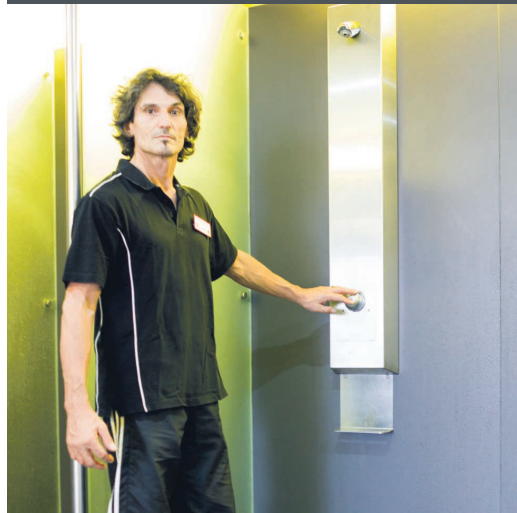
Der Fitnesstreff Niklaus AG in Reinach (AG) investiert in Wärmerückgewinnung, Spardüsen und Selbstschlussarmaturen.
