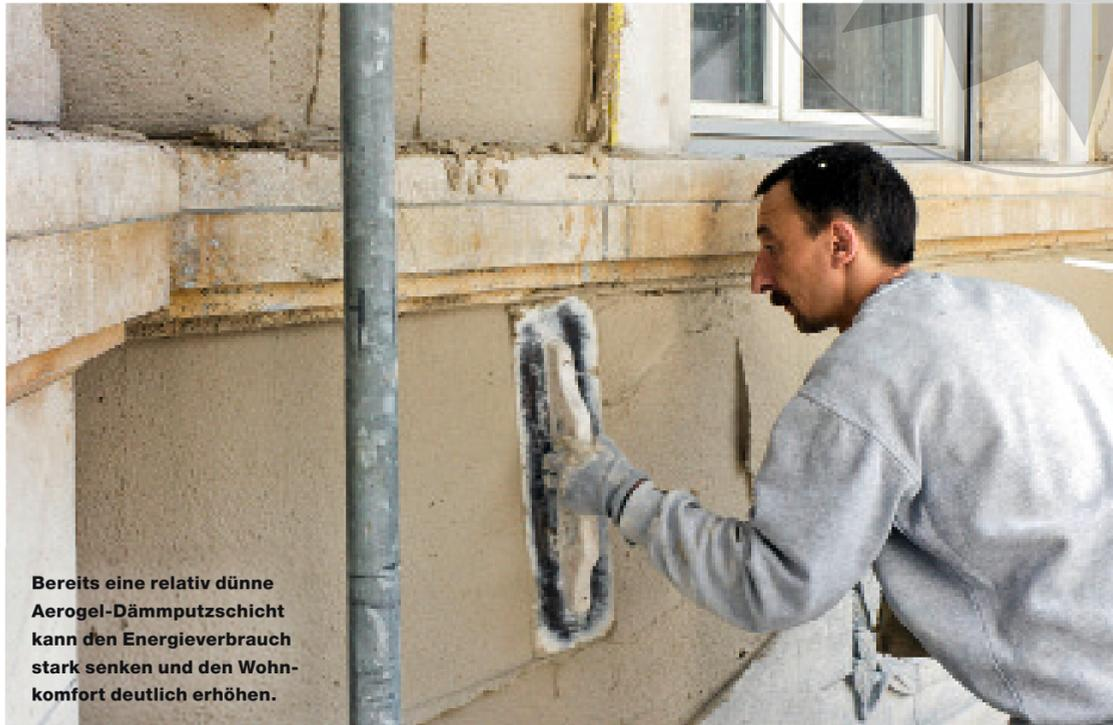
**Bereits eine relativ dünne Aerogel-Dämmputzschicht kann den Energieverbrauch stark senken und den Wohnkomfort deutlich erhöhen.**
