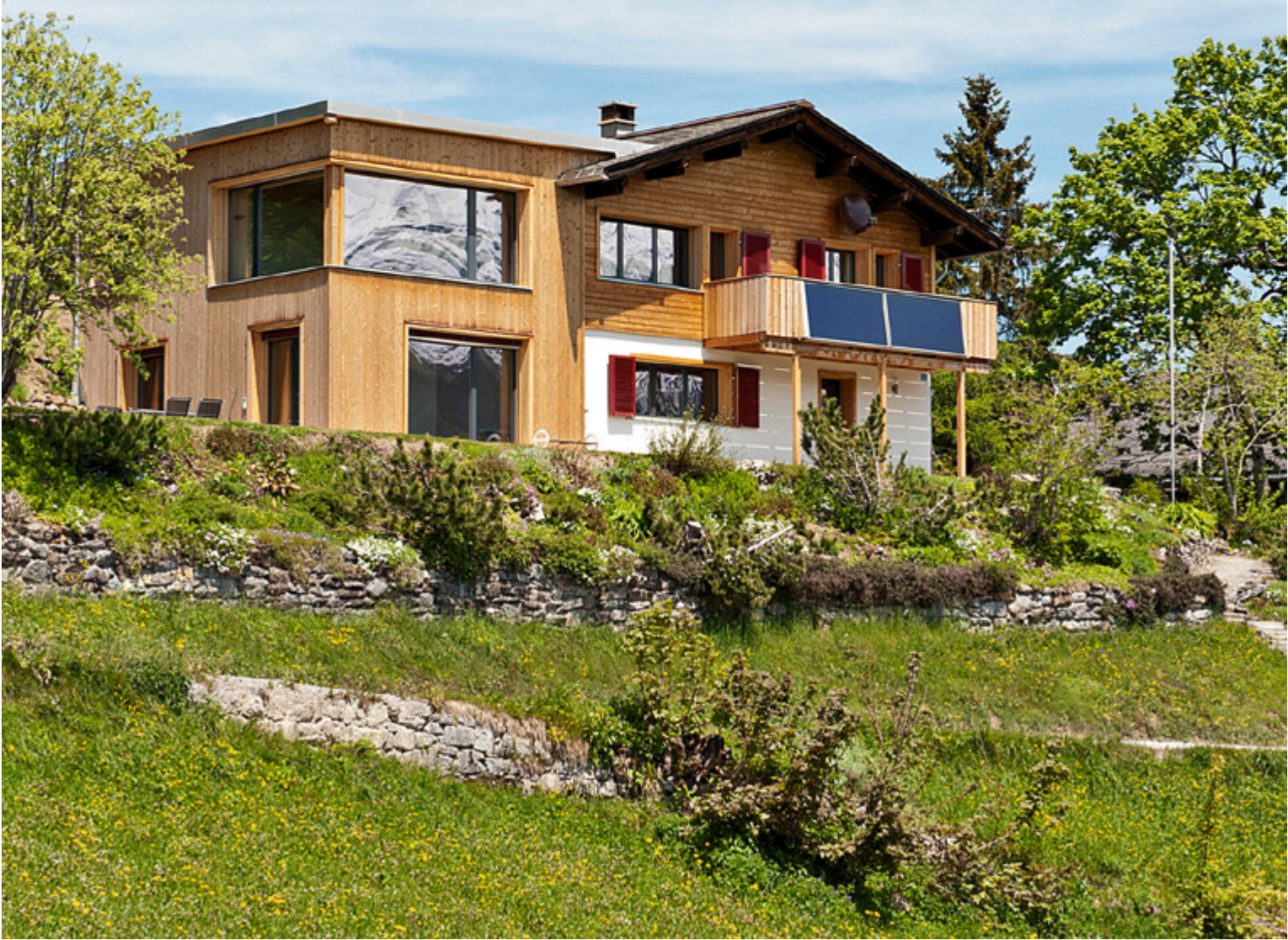
Harmonische Kombination aus Alt und Neu: Minergiezertifiziertes, energetisch saniertes und modern erweitertes Chalet in Braunwald.
