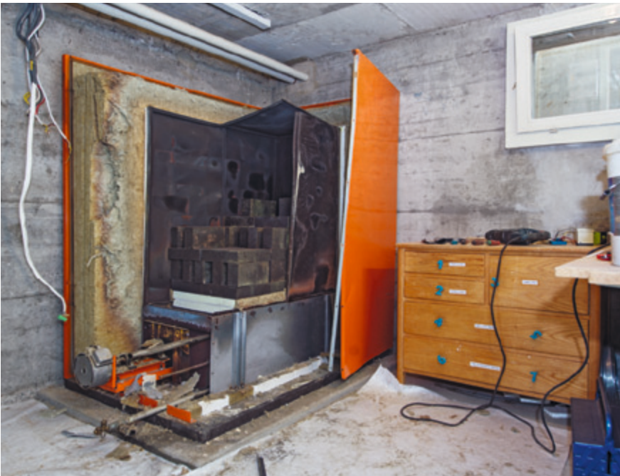
Die alte Elektroheizung im Keller wird demontiert.
