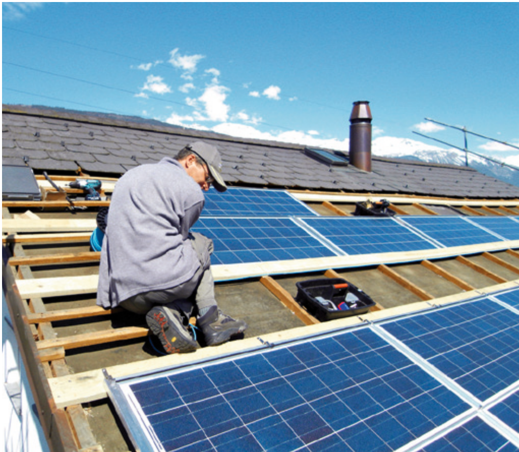
Optimale Ausführung zahlt sich aus: Installation einer Photovoltaik-Anlage.
