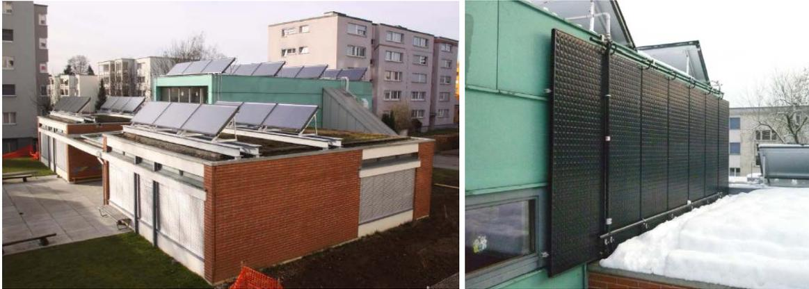
Abbildung 43: Kollektoren der Pilotanlage mit Eisspeicher des SPF in Rapperswil (Philippen, 2013)
