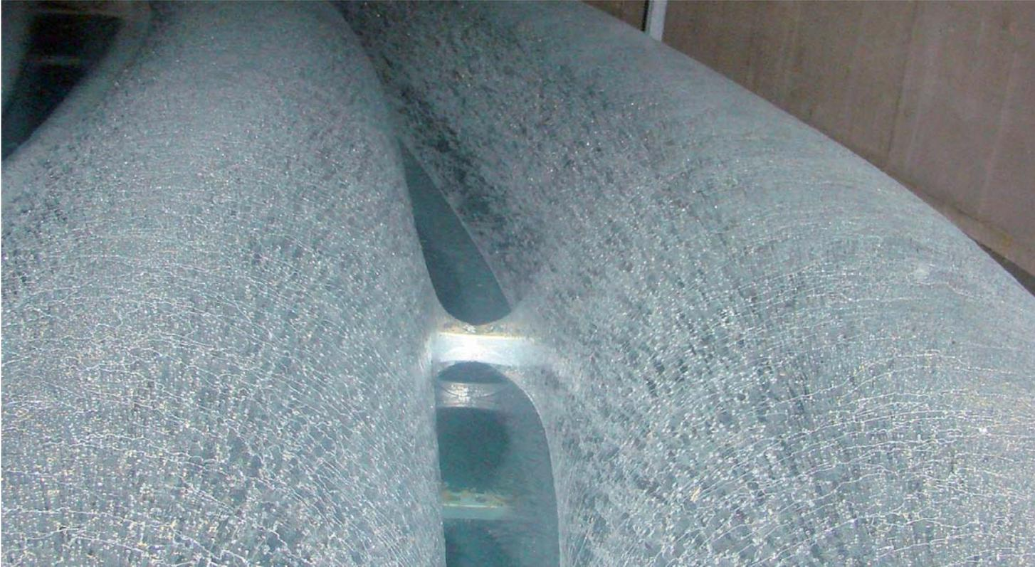
Eisbildung um den Entzugswärmetauscher im Eisspeicher
