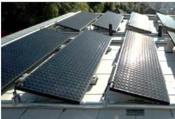
Verglaster, selektiver Flachkollektor mit aktiver Hinterlüftung (Ventilator); z.B. Consolar Solaera Hybridkollektor
