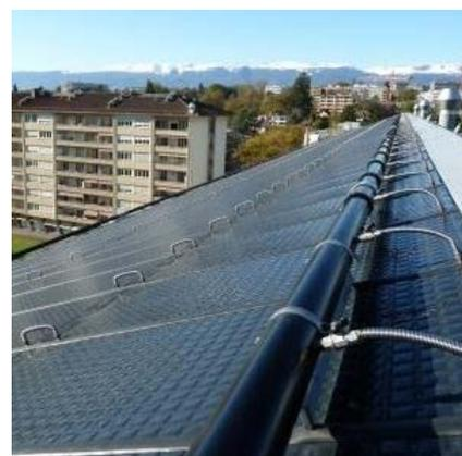
Abbildung 47: Links: Wohnüberbauung La Cigale in rue Vermont / rue Vidollet; rechts: Unverglaste Solarkollektoren als Dachersatz (Solardach AS, Bilder: Energie Solaire SA)
