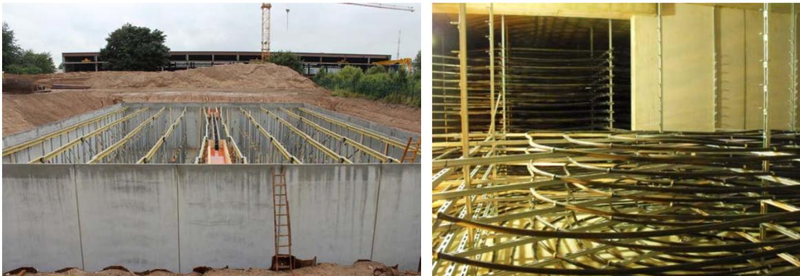
Abbildung 49: Links: Eisspeicher von Ecolab in Monheim (D), Dimension 20 m × 25 m × 5 m); rechts: Isocal-Rohrbündelwärmetauscher im Innern des Eisspeichers (Bilder: [www.pbs-partner.de](http://www.pbs-partner.de))
