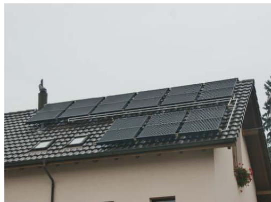
Abbildung 17 und Abbildung 18: Viessmann Solar-Luft-Absorber SLK-S; 5 Stück links, 9 Stück rechts
