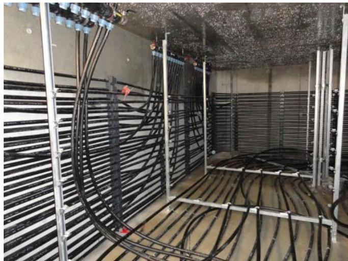
Abbildung 51: 116 m<sup>3</sup> Eisspeicher von Isocal während des Ausbaus
