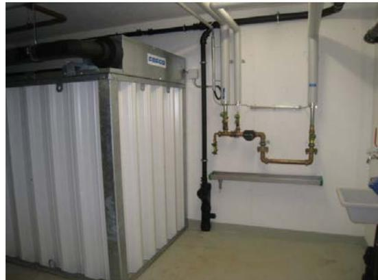
Abbildung 52: Links: 90 m<sup>2</sup> Energie Solaire AS Kollektorfeld auf Schrägdach; rechts: Innenaufgestellter FAFCO Eisspeicher, 9 m<sup>3</sup> Behältervolumen
