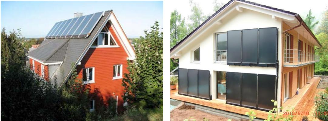
Abbildung 28: Dachmontage auf renoviertem Altbau und Fassadenmontage an Neubau
