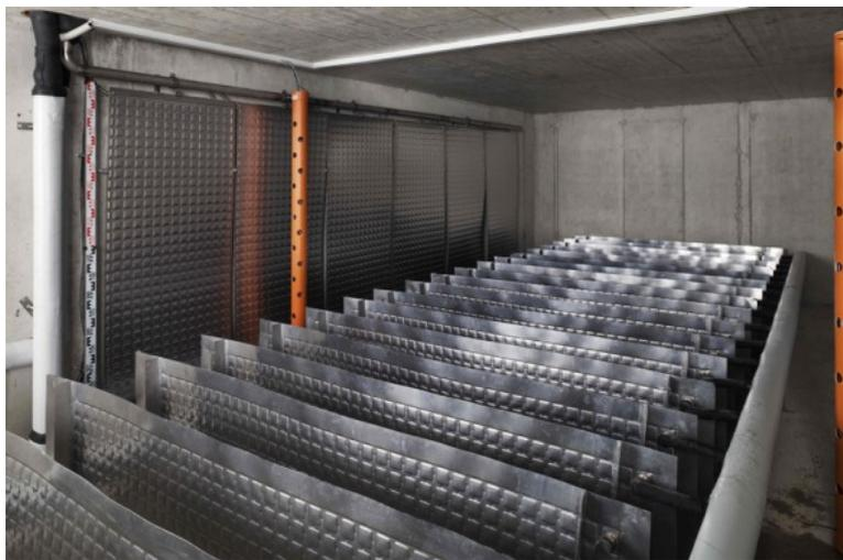
Abbildung 44: 75m<sup>3</sup> Eisspeicher der SPF Versuchsanlage mit flächigen Wärmetauschern im unteren Bereich und an den Seitenwänden (Philippen, 2013)
