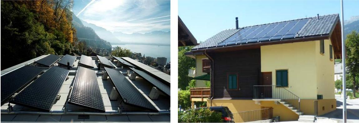
Abbildung 35: Energie Solaire Kollektoren; links: Kollektor AS, aufgeständert (Bild: Energie Solaire SA); rechts: 25 m<sup>2</sup> Solardach AS, dachintegriert, kombiniert mit Solaera Eisspeicher-Wärmepumpe (Bild: Weisskopf Partner GmbH)
