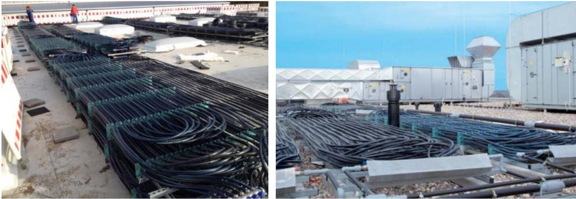
Abbildung 50: PE-Schlauch Kollektoren auf dem Dach von Ecolab, Monheim (D); 66 Kollektoren mit ca. 550 m<sup>2</sup> (projizierter) Fläche. Mehrere Schlauchebenen zur Erhöhung der Wärmetauscherfläche
