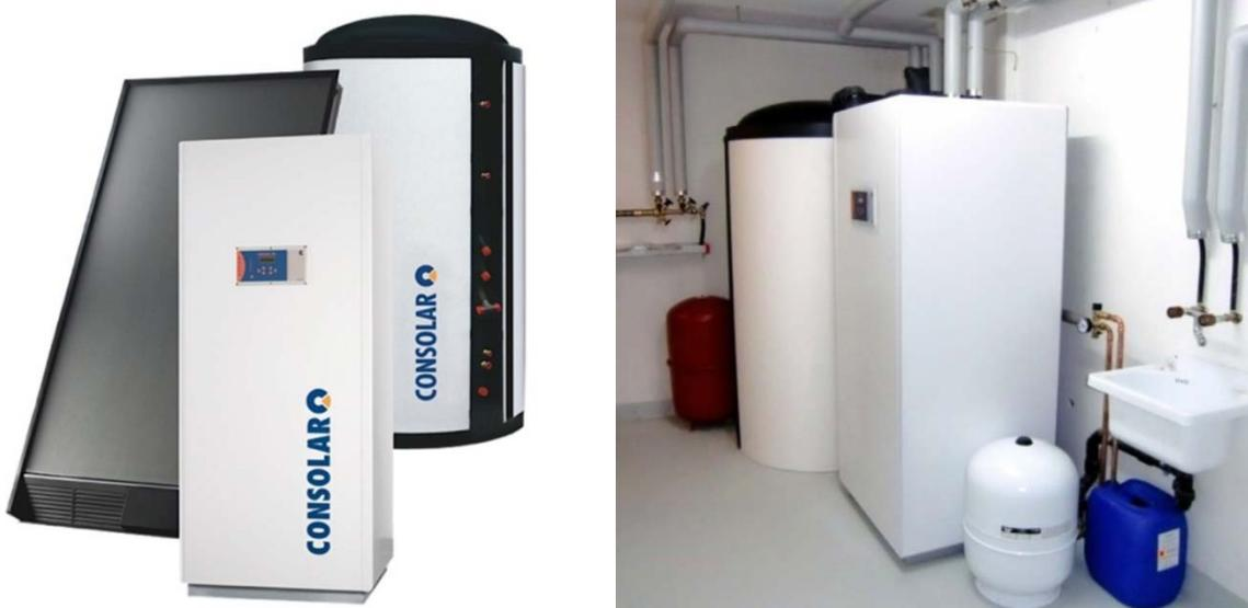
Abbildung 30: Consolar Energiezentrum, links: Katalogbild, rechts im Einsatz; Im Gehäuse sind unten Eisspeicher, oben Wärmepumpe, Steuerung und hydraulische Komponenten untergebracht. Daneben ist der der zylindrische Wärmespeicher zu sehen.
