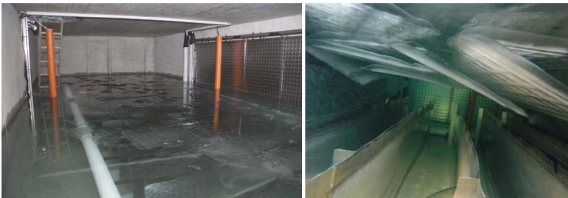
Abbildung 45: Links: Teilweise gefüllter 75 m<sup>3</sup> Eisspeicher der Versuchsanlage des SPF. Auf der Wasseroberfläche ist Eis zu erkennen, dass durch "de-icing" von den Kollektoren abgelöst wurde; rechts: Unterwasseraufnahme mit vereisten Wärmetauschern und abgelösten Eisplatten im Wasser (Philippen, 2013)
