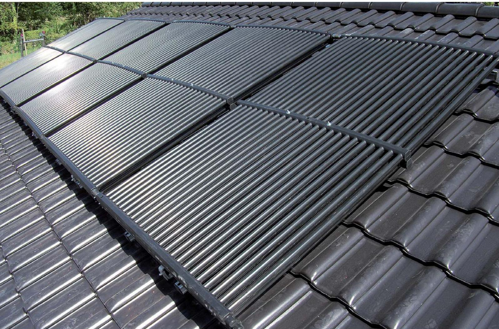
Solar-Luftabsorber, hier in Schrägdachmontage, als direkte Wärmequelle für die Wärmepumpe oder zur Regeneration des Eisspeichers
