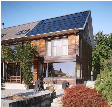
Bild 2: Gebäudeintegrierte PV-Anlage in Mettmenstetten, Schweiz (Foto: www.bipv.ch )
