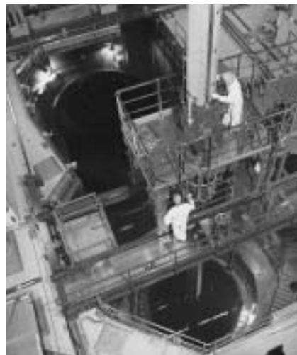
Ein Viertel der Brennelemente werden jährlich aus dem Reaktor entnommen. Sie klingen in einem separaten Wasserbecken ab.
