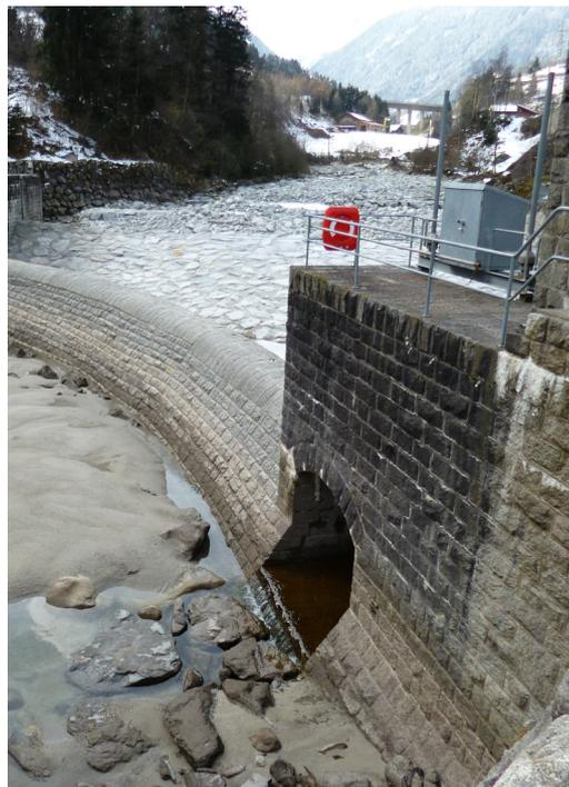
Das Leitwehr bei Wassen (UR) staut die Reuss, damit Wasser und Geschiebe bei Bedarf in den Umleitstollen (rechts hinter der Mauer) geleitet werden können. Foto: B. Vogel
