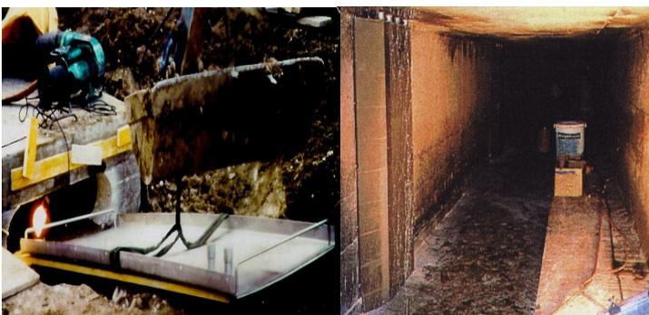
**Abb. 17: Rinnenwärmetauscher für Kanäle mit Rechteckprofil**
