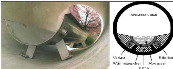
**Abb. 19: Rinnenwärmetauscher für Kanäle mit Kreisprofil**
