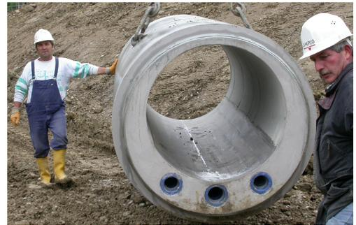
**Abb. 21: Rinnenwärmetauscher als vorgefertigte Kanalisationselemente**
