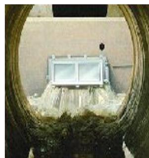
**Abb. 22:** automatische Schwallspülung für grosse Kanäle
