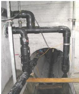
Abb. 5: Vor- und Rücklaufleitungen des WT in Binningen
