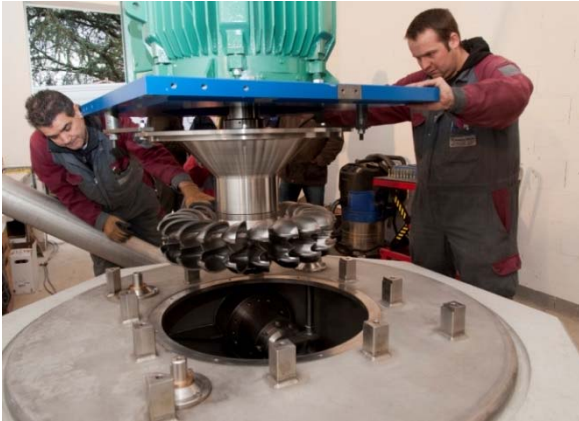
Montage der neuen Turbineneinheit im Abwasserwerk Coppet, www.sitse.ch/new/epuration.php 19
