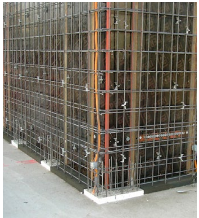
Abb.: Wandarmierung mit wärmedämmten Anschlusselementen auf Betonplatte
