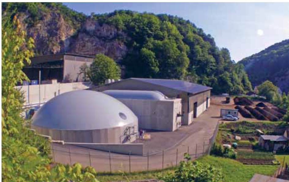
Abbildung 164: Biopower-Anlage Liesberg (BL), kombinierte Vergärungs- und Kompostierungsanlage.
