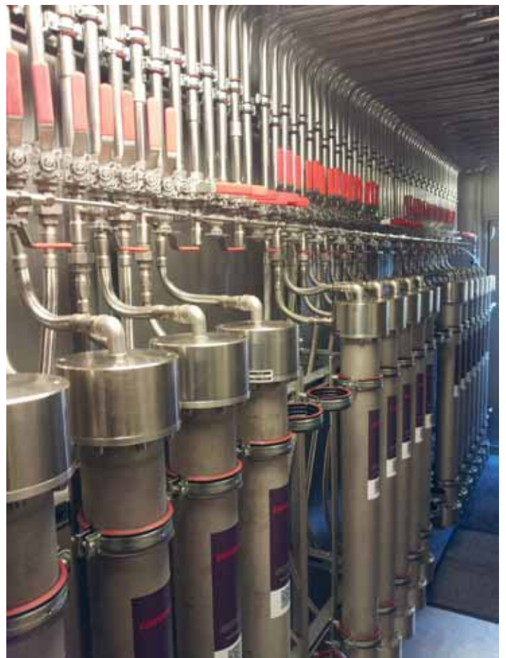
Abbildung 174: Bio- power-Anlage Prat- teln – Biogasreini- gungsanlage
