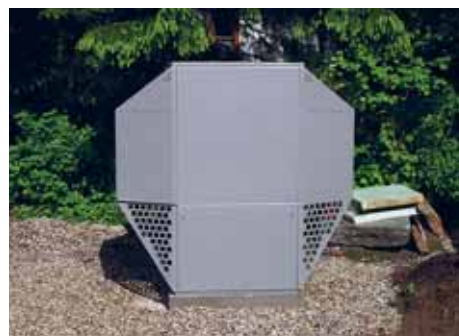
Abbildung 100: Aussen-Aufstellung Wärmepumpe.
