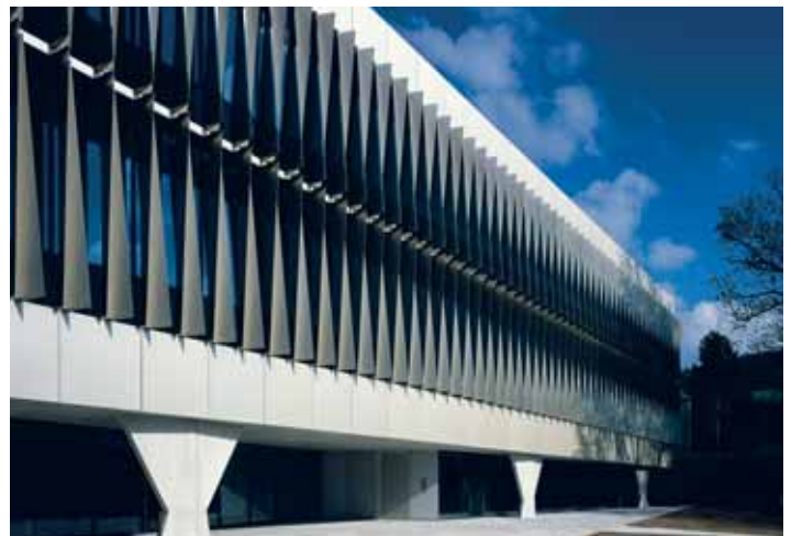
Abbildung 13: Neubau Pathologie und Rechtsmedizin des Kantonsspitals St. Gallen. Passive Kühlung mit Erdsondenfeld; Heizung mittels Abwärme aus Rechenzentrum und Erdsondenwärmepumpe (Helen Binet).
