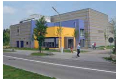
Abbildung 190: Beispiel Unterhaching: das Pilotprojekt im Grossraum München versorgt rund 3000 Haushalte mit Fernwärme und rund 6000 Haushalte mit Strom.
