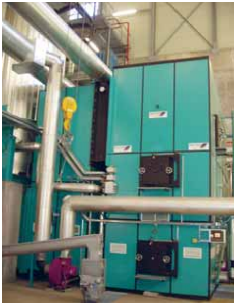
Abbildung 144: Holzfeuerung mit Thermoölkessel (Sägewerk Echtle KG).
