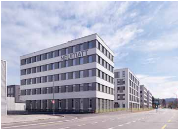
Abbildung 210: Neubau Verwaltungsgebäude in Burgdorf mit einer Heizung und einer Kühlung mit Grundwasser, das als Wärme- respektive Kältequelle dient (Dr. Eicher + Pauli AG).
