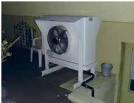
Abbildung 97: Verdampfereinheit im Freien.
