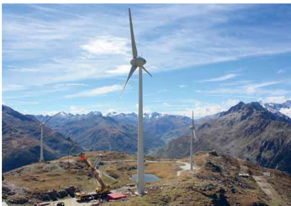
Abbildung 184: Windpark auf dem Gütsch bei Andermatt. Dank der bestehenden militärischen Anlagen waren die Erschliessungskosten relativ gering (EW Ursern, Markus Russi).
