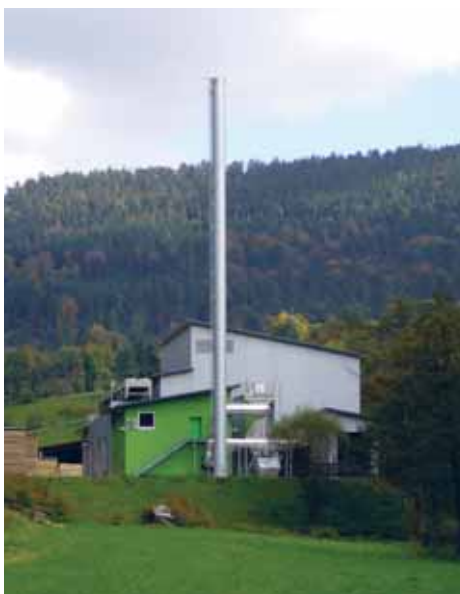
Abbildung 145 Abbildung 146: Holzkraftwerk mit ORC-Anlage in Nordrach, Deutsch- land (Sägewerk Echtle KG).
