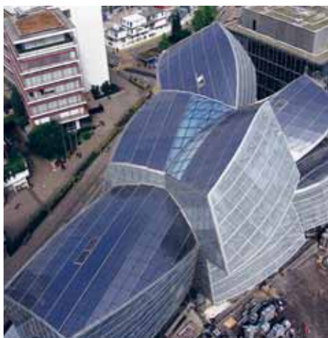
Abbildung 57: Gebäudeintegrierte PV-Anlage auf dem Novartis-Campus in Basel.
