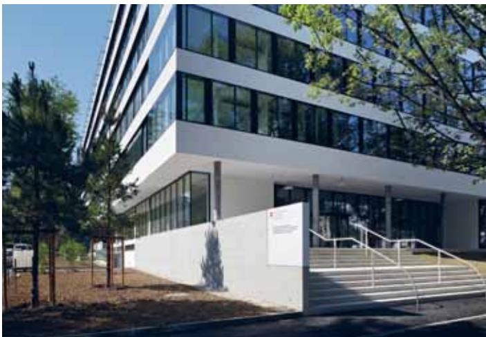
Abbildung 12: Das nach Minergie zertifizierte Hauptgebäude des Bundesamtes für Bauten und Logistik (Marco Schibig).
