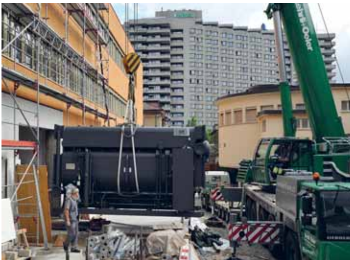
Abbildung 212: Absorptionskälteanlagen des Inselspitals Bern, betrieben mit Abwärme aus den Kehrlichtverbrennungsanlagen von Energie Wasser Bern (EWB).
