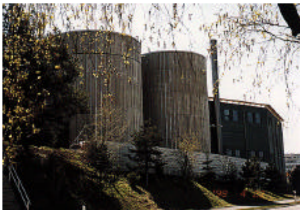
Fig. 5 Biogasanlage der E. Flachsmann AG in Wädenswil
