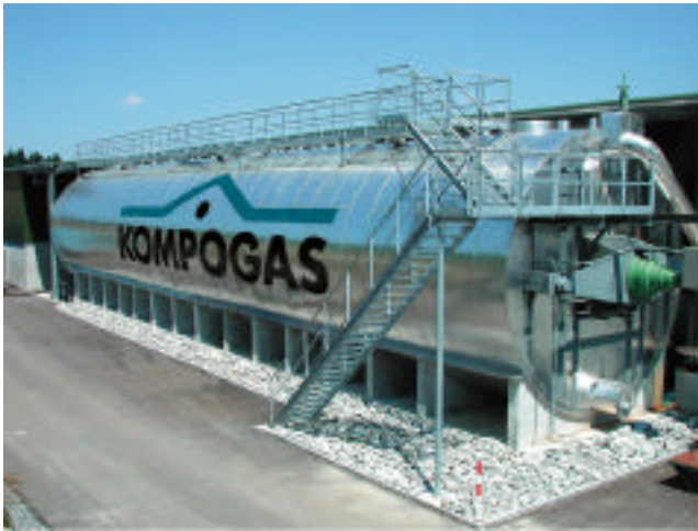
Fig. 17: KompoGas Anlage Oetwil a. See
