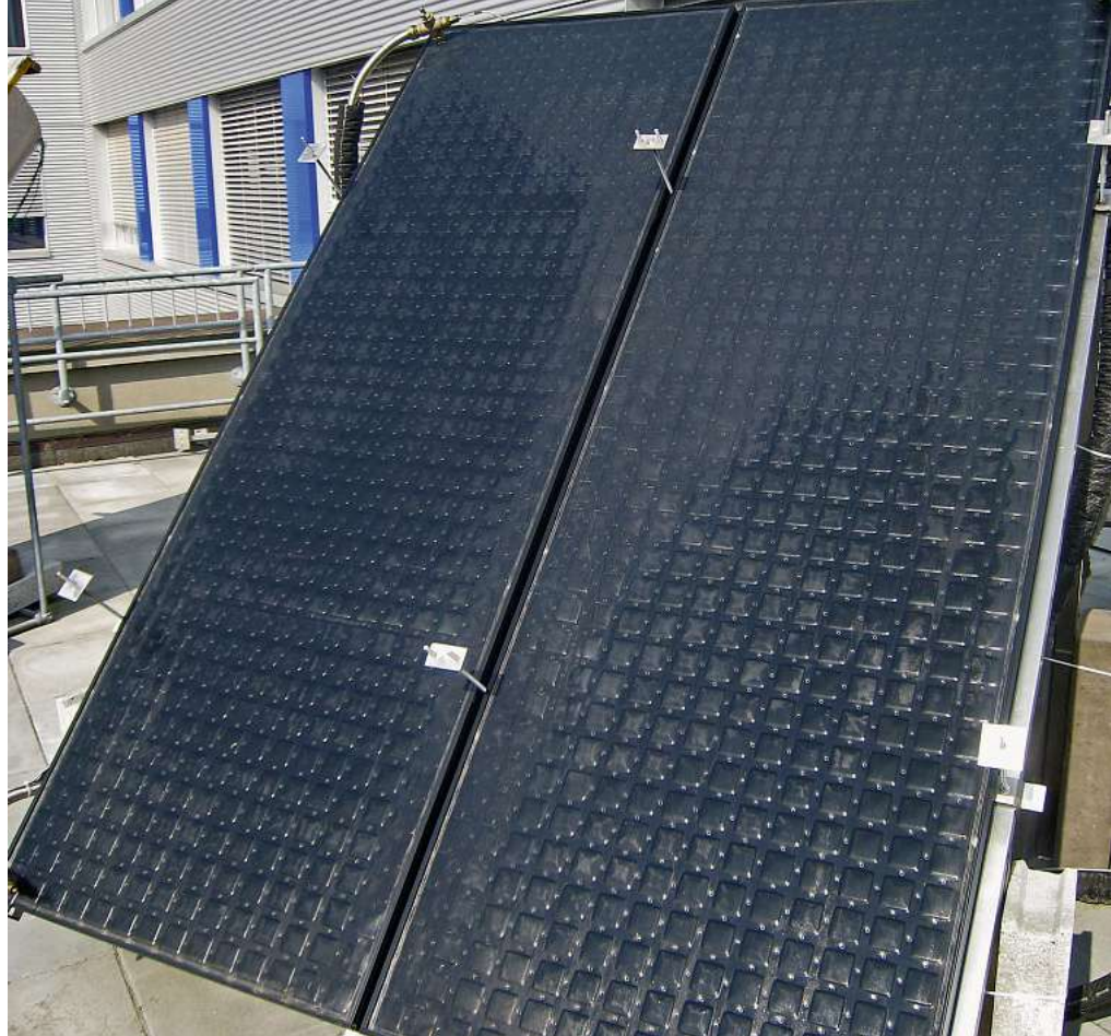
Für die Kombination mit der Wärmepumpe genügen günstige, unverglaste Kollektoren.
