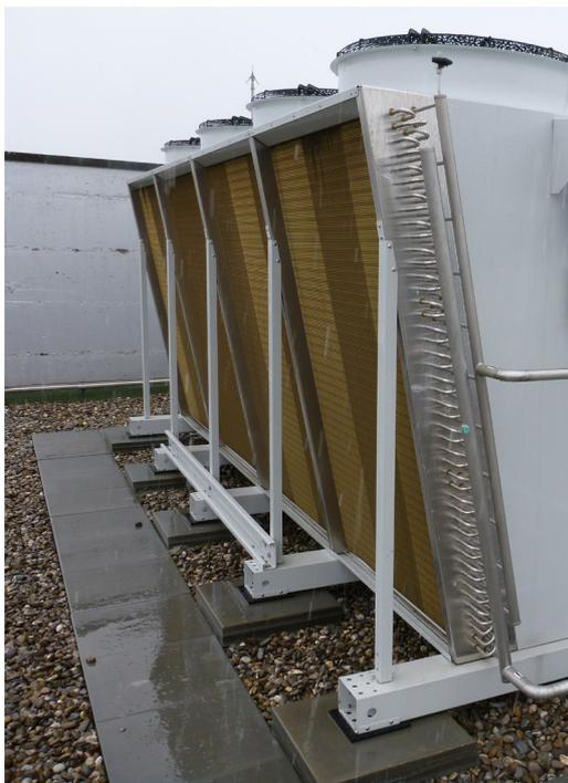
Der luftgekühlte Gaskühler auf dem Dach ist ein Teil der zentralen Kälteanlage. Überschüssige Wärme wird mittels Gaskühler an die Umgebung abgegeben. Foto: FCAG
