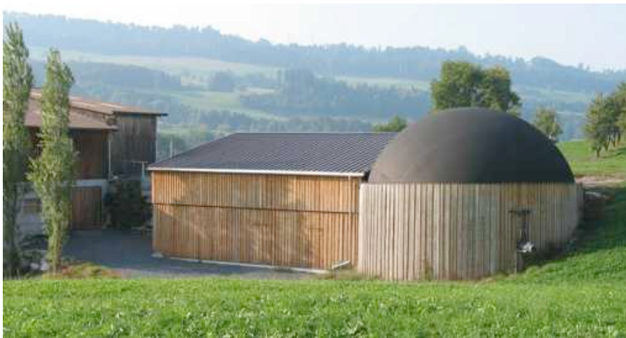
Fig. 17: Betriebsgebäude mit Fermenter und Gasballon
