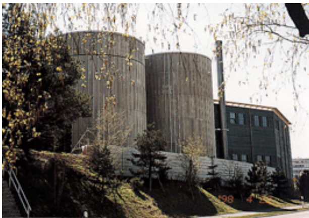
Fig. 5 Biogasanlage der E. Flachsmann AG in Wädenswil
