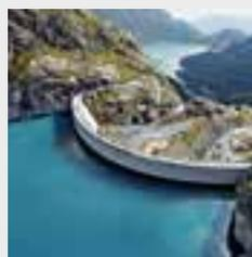
Das Pumpspeicherkraftwerk Nant de Drance nutzt für die Pumpspeicherung das Gefälle zwischen dem Stausee Vieux Emosson und dem 295 Meter tiefer gelegenen Stausee Emosson. Das Kraftwerk Nant de Drance wird mit sechs neuen Turbinen à je 150 Megawatt ausgestattet. Zudem wird die Staumauer des Stausees Vieux Emosson um 20 Meter erhöht.
