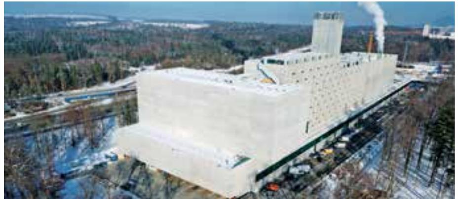
Von aussen sieht die Energiezentrale aus wie ein gewaltiges Containerschiff aus Beton: Zuerst die Kommandobrücke, die eigentlich der Kehrlichtbunker ist. In der Mitte der mächtige Aufbau mit Kamin, der die Kehrlichtverbrennung, das Holzheizkraftwerk sowie das Gas-und-Dampf-Kombikraftwerk beherbergt. Und schliesslich der Bug hinten im Bild, in dem das Servicegebäude untergebracht ist. Der Frachter fährt unter der Flagge von Energie Wasser Bern und ist auf Kurs Richtung Atomausstieg.
