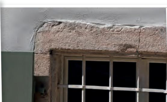
Aerogel-Dämmputz lässt sich so dünn aufs alte Mauerwerk auftragen, dass Fenstergewänder nicht verdeckt werden.
