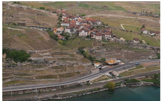
Luftaufnahme des UNESCO Weltkulturerbes, mit dem Dorf Rivaz, dem Bach Forestay, der Kraftwerkszentrale (zwischen Strasse und Ufer) und dem Verlauf der Richtbohrung
