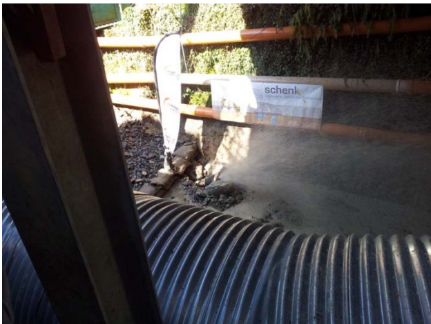
Ankunft des Bohrkopfs im Bereich der zukünftigen Wasserfassung
