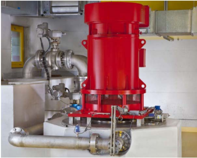
Die zweidüsige Pelton-Turbineneinheit
