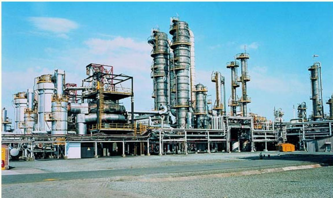
Rektifikationsanlage zur Ethylbenzol-Styrol-Trennung
