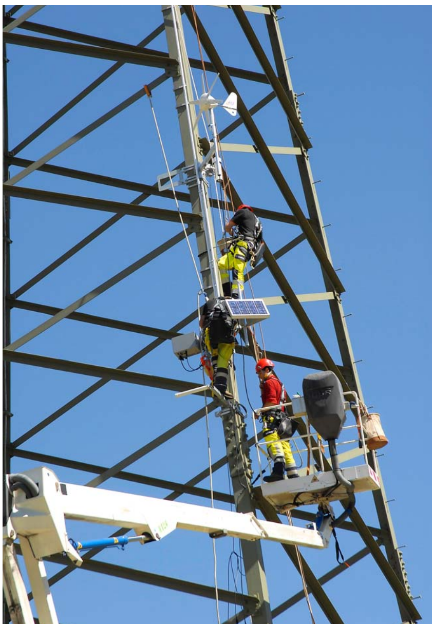
Monteure befestigen das Solarpanel sowie den Windgenerator für die Energieversorgung der Messstation in La Punt. (Bild: Horst Hopitz)
