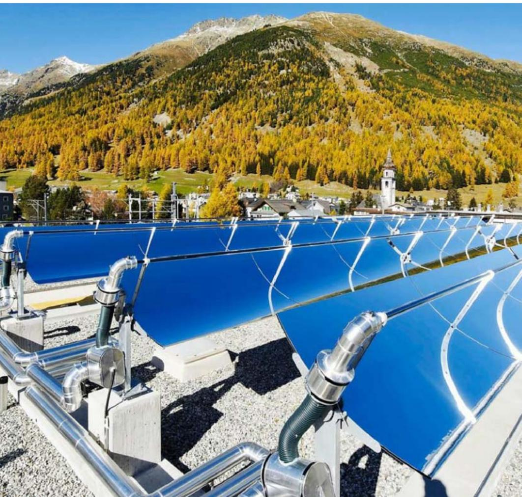
Auf dem Dach der LESA in Bever GR erzeugen Parabolrinnen-Kollektoren der NEP Solar AG Prozesswärme aus der Sonneneinstrahlung. (Bild: © ewz)
