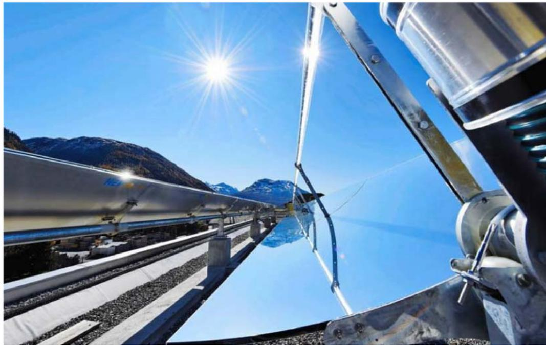
Die Parabolrinnen werden der Sonne nachgeführt und reflektieren die Strahlung auf ein Absorberrohr, in dem ein Thermoöl als Wärmeträgermedium zirkuliert. Typische Betriebstemperatur: etwa 180°C (Bild: © ewz)
