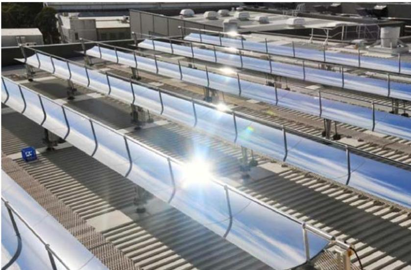
Auch solare Kühlung ist mit Parabolrinnen-Kollektoren realisierbar, wie eine 230-kW-Installation (354 m<sup>2</sup>) in Newcastle (AUS) bestätigt. (Bild: NEP Solar)
