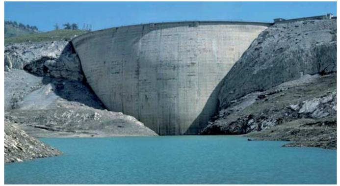
**Bild 8. Durch den Bau eines Sondierstollens hat sich eine Verformung der Zeuzier-Staumauer ergeben, so dass zunächst eine Wasserabsenkung und anschliessend Injektionen erforderlich waren. (Quelle: www.swissdams.ch)**
