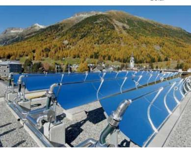
Auf dem Dach der LESA in Bever / GR erzeugen Parabolrinnen-Kollektoren der NEP Solar AG Prozess-wärme aus der Sonneneinstrahlung
