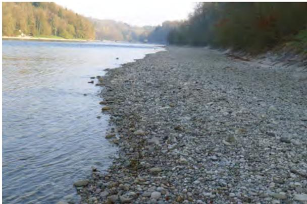
*Bild 8.1 Kiesbank Rheinau am 5. April 2011, 4.5 Jahre nach der Schüttung. Blick gegen Fließrichtung ( $Q = 236\text{m}^3/\text{s}$ ).*
