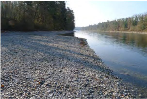
Bild 8.3 Kiesbank Wolfsgrube am 5. April 2011, 4.5 Jahre nach der Schüttung. Blick gegen Fließrichtung ( $Q = 236\text{m}^3/\text{s}$ ).
