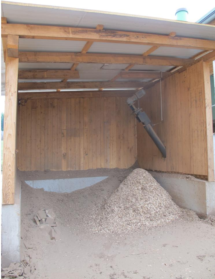
*Figur 18: Staub und Feinanteile werden ausgesiebt und abgeschieden.*
