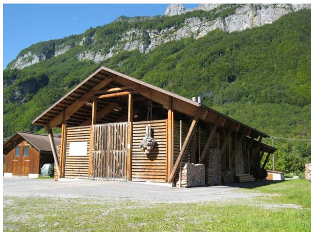
Figur 41: Wärmeverbund Linthal: Schnitzellager mit der Heizzentrale im Untergeschoss.
