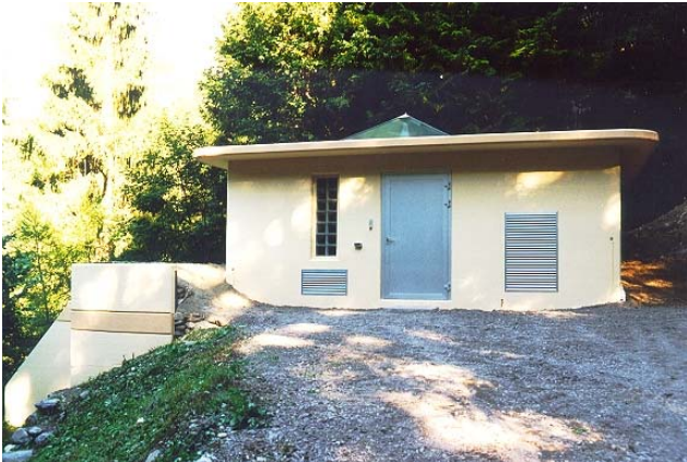
Das Trinkwasserkraftwerk La Rasse, installiert im Trinkwasserreservoir der Gemeinden St-Maurice und Evionnaz
