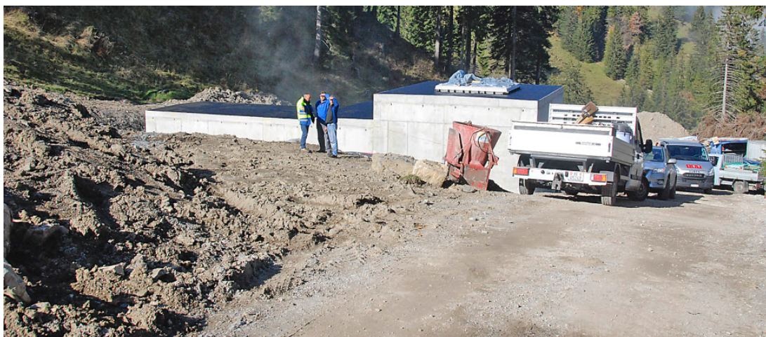
Das Gebäude der Wasserversorgung Blattenheid auf der gleichnamigen Alp oberhalb von Blumenstein. Die Turbine zur Stromerzeugung ist im erhöhten Gebäudeteil rechts untergebracht.
