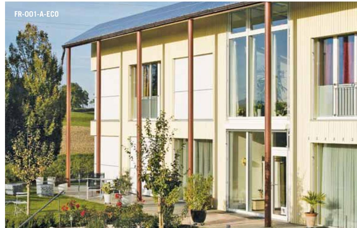
**Das Haus besteht aus zwei Gebäudeteilen, verbunden durch einen vollverglasten Wintergarten. Nur ein Teil ist unterkellert; der Rest steht auf Streifenfundamenten. Die Aussenhülle wurde mit Zellulosefasern ausgeblasen und ist mit 40 Zentimetern sehr gut gedämmt. Die Holzwände sind winddicht und dampfdiffusionsoffen, also**
