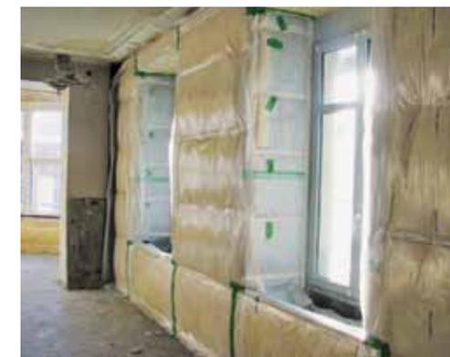
**Die Gebäudehülle wurde komplett erneuert, einschliesslich Dämmung und Fenstern, die den gesetzlichen Vorschriften entsprechen. Die alte Ölheizung wurde durch eine innen aufgestellte Luft/Wasser-Wärmepumpe ersetzt. Aufgrund der neuen Erdbebenschutzvorschriften musste auch das Tragwerk des Gebäudes verstärkt werden. Weil das Haus denkmalgeschützt ist, erfolgte die Dämmung der Fassade zum grössten Teil auf der Innenseite.**
