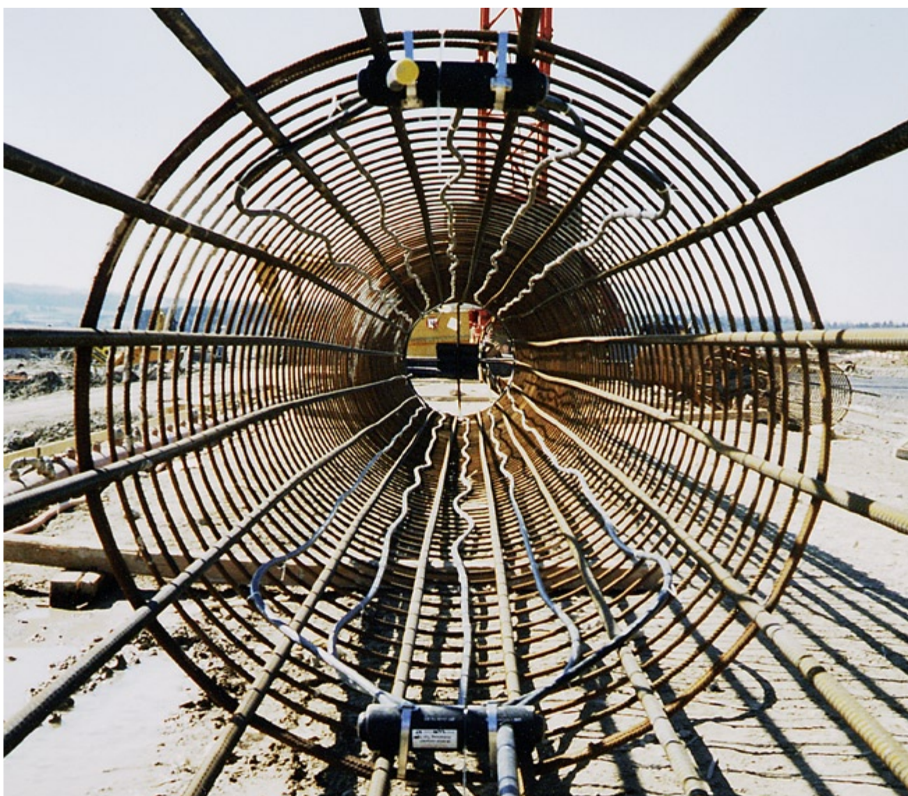
Energiepfähle, wie sie beim Bau des Flughafens Zürich zum Einsatz kamen, sorgen für Wärmeaustausch und Stabilität.
