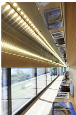
Fenster und Fassadendämmung (unten rechts) wurden erneuert, die Villa weist heute bessere Dämmwerte aus als ein Minergie-Haus. Bei der Beleuchtung kommen nur noch LED zum Einsatz.
