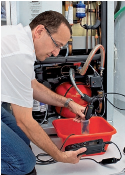
Sorgfältige Wasseranalyse vor der Sanierung.
